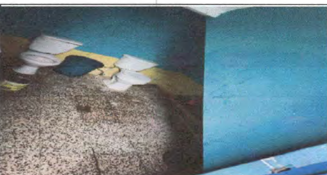
Foto 6: Sustitucion de inodoro.
