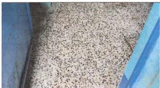
Foto 3: Sustrucción de piso cerámico
