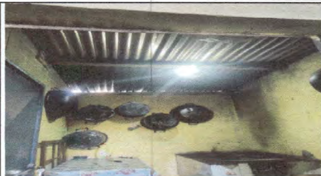
Foto2: Sustitucion de lamina, por lámina troquelada aluzinc calibre 26.
