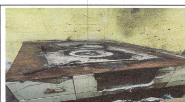
Foto 4: Sustitución de plancha de metal de 3 hornillas.
