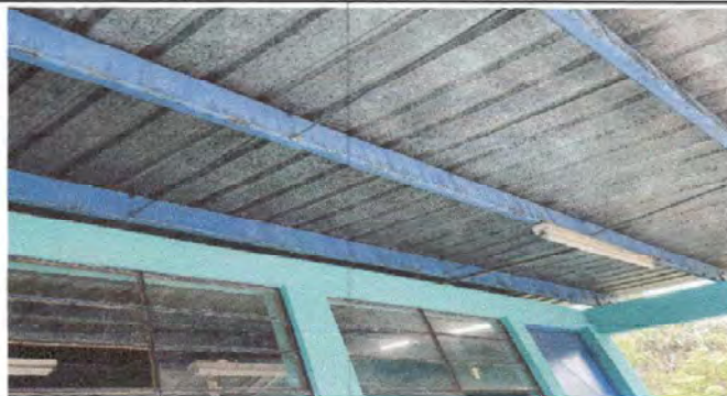
Foto 2: Mantenimiento a estructura de soporte de metal.
