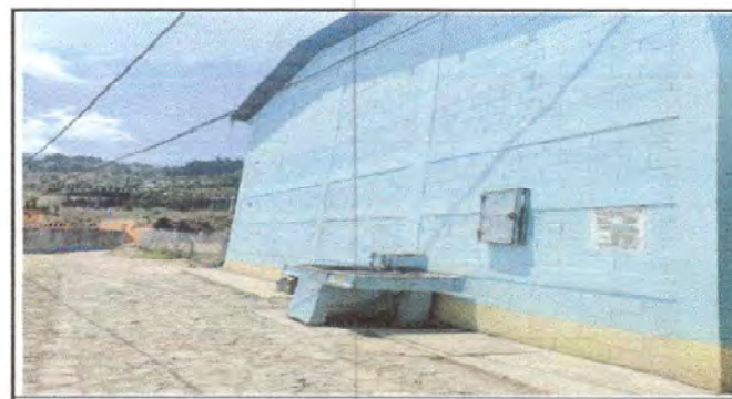
Foto 6: Pintura de muros exteriores e interiores.
