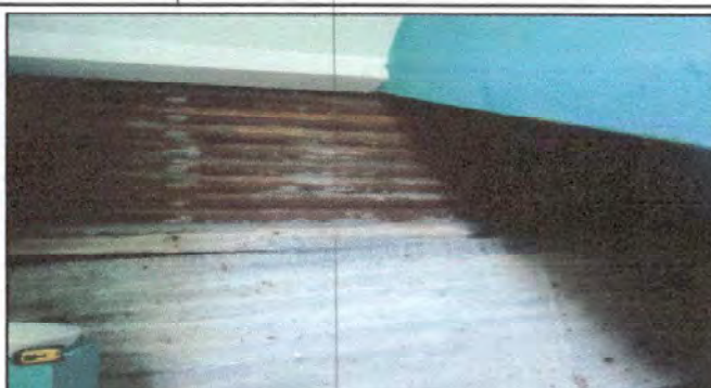
Foto 2: Sustrucción de entrapaño de metal.
