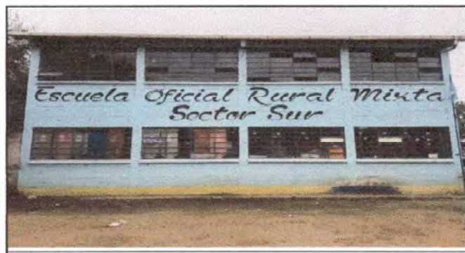
Foto 5: Sustitución de vidrios.
