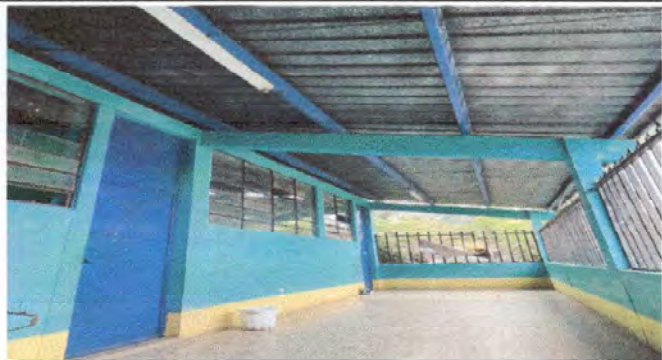
Foto 1: Sustitución de lamina por lamina troquelada calibre 26 en aulas.
