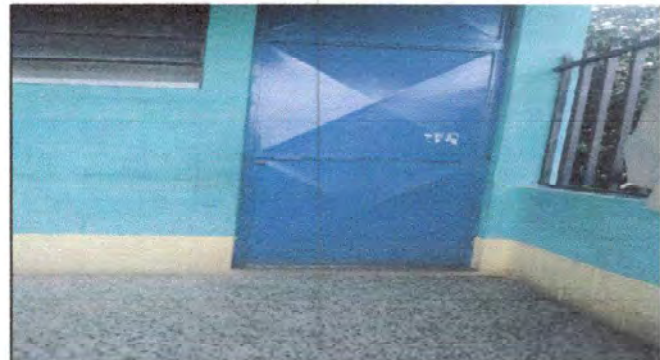
Foto 4: Sustitución de Chapa
