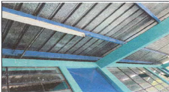
Foto2: Reparación de lámparas.
