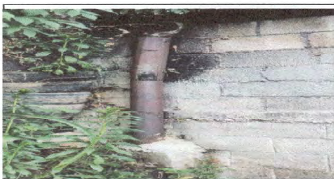
Foto 5: Sustitución de chimenea de metal.
